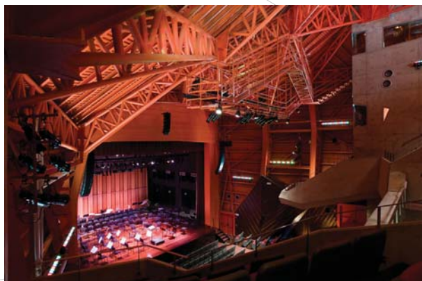
vista general - estructura metálica
