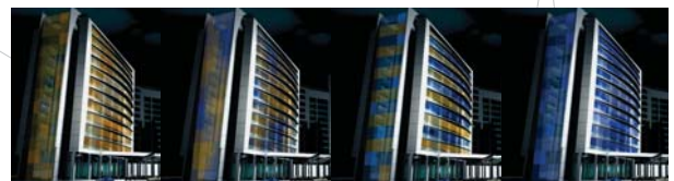
prueba de iluminación
